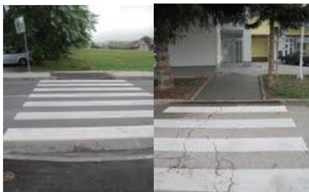
↳ Fotografiji 21, 22: Prehod za pešce pred upravno stavbo občine, zdravstvenim domom in večnamensko dvorano.
